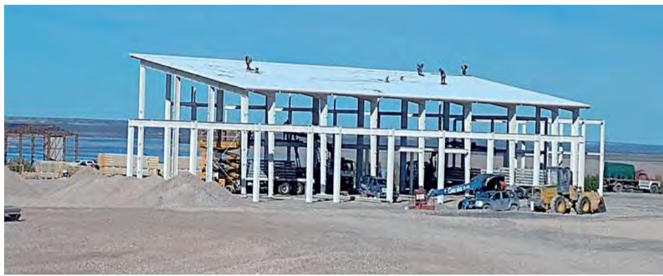
Durante la recorrida se apreció el avance de obra de la Bodega provincial, enclavada en un sitio estratégico, donde en principio se podrá elaborar 350.000 litros de vino al año.
