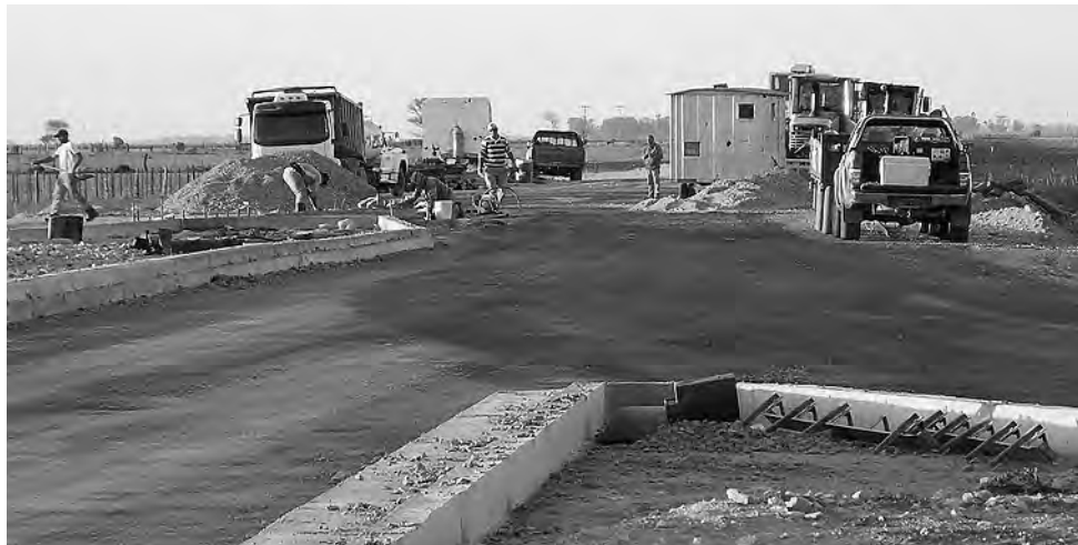
Cruce y ruta en construcción sobre RP Nº 2 a Falucho entre Ojeda y Alta Italia. "Con recursos que ha provisto la Provincia y Nación, de 260 kilómetros de caminos terciarios hemos logrado controlar el 60%, el agua arrasó todo", lamentó Oscar Flores.
