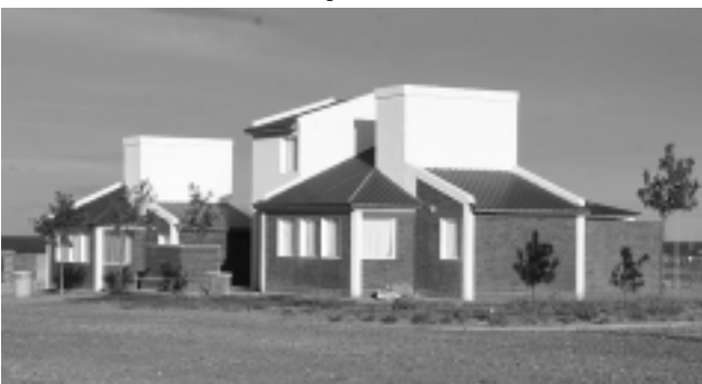
«Cabañas de Piedra», uno de los establecimientos hoteleros pampeanos actualmente en marcha en la Villa, junto al gran lago.
