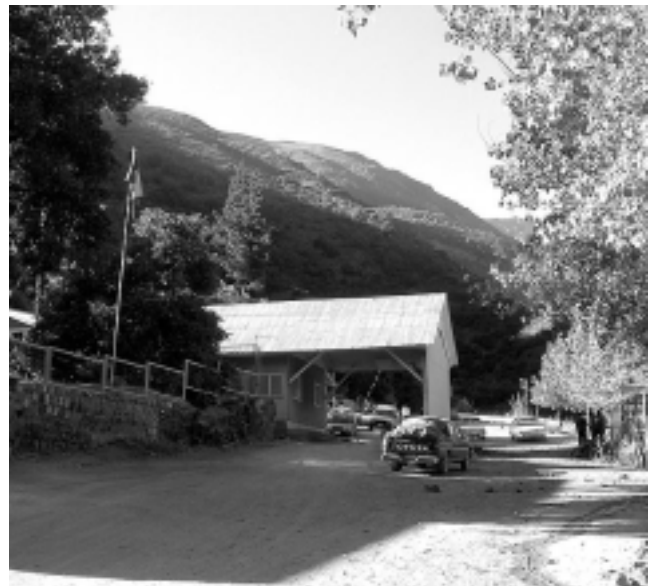
El Centro de Control Integrado (Aduana, Migraciones y Sanidad de ambos países) será de cabecera única y estará en territorio argentino, cuya infraestructura deberá ser capaz de adaptarse frente a posibles incrementos de flujo de operaciones, por ejemplo contemplar su ampliación.
