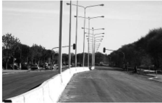
En la Remodelación integral de la Ruta Nacional N° 35 en correspondencia con la Av. de Circunvalación a Santa Rosa, se destaca la ampliación de la capacidad de circulación de vehículos mediante la construcción de dos carriles en cada sentido, divididos por baranda de hormigón, más colectoras a cada lado. Se incluye la iluminación total desde la Rotonda Sur a la Rotonda Norte, la construcción de catorce cruces a nivel semaforizados, tres cruces aéreos para peatones y el cruce con el ferrocarril.
