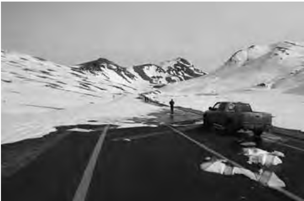
La licitación que la DNV anunció en Mendoza durante la semana, es solamente de 36 kilómetros -desde Cajón Grande hasta Hito Pehuenche-, sobre los casi 60 que faltan pavimentar. Los 20 km restantes corresponden a la franja que va desde el km 18,5 de la ruta 145 hasta Cajón Grande, que quedó pendiente, porque desde hace años no se ponen de acuerdo Mendoza y Nación sobre la realización o no del dique Portezuelo del Viento, que de concretarse dejaría bajo el agua este tramo.
