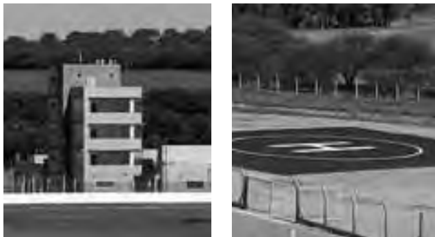
Torre de Control, Sala Técnica, Periodismo, Podio y al lado el Helipuerto.
