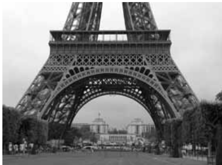
Aunque en los bosquejos iniciales de Stephen Sauvestre, los arcos aparecían muy decorados, lo son mucho más hoy en día, pero tienen sobre todo una función arquitectónica: endurecer la estructura de la base.
