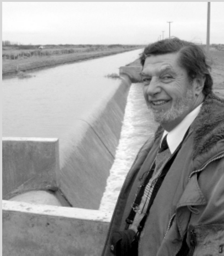
El Ing. Duccoli junto a la obra de cabecera en el predio de la empresa «Zille», donde se construyó el decantador con vertedero longitudinal.
